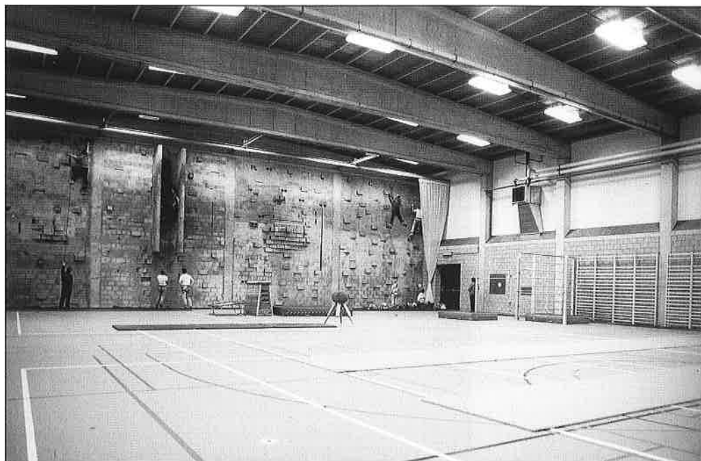
Sporthal De Mispelaer Nieuwkerken: zicht op de klimmuur
