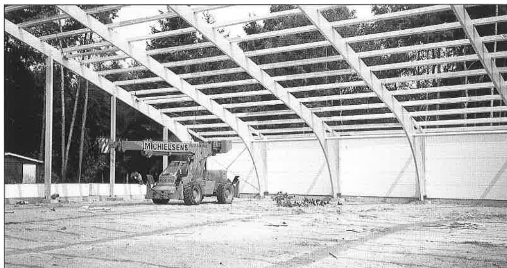
De indoorhal in opbouw...
