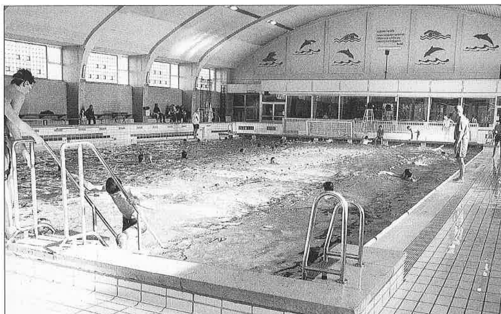
In 1992 werden de opstaande zijmuurtjes vervangen door gelijkvloerse overloopgoten
